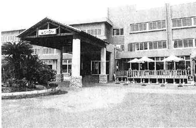
全面リニューアルが完了し「食彩の宿 いいおか」と名称変更もしたが、県の防災改善指導を受けていたことが分かった
